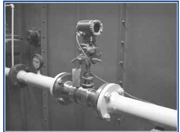
Accelabar offre une précision élevée sans longueur droite requise
