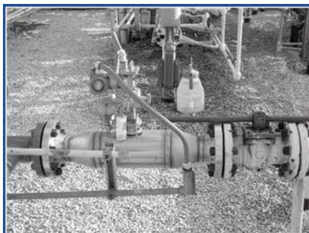
Une usine chimique a installé Accelabar pour s'adapter à des hausses futures
