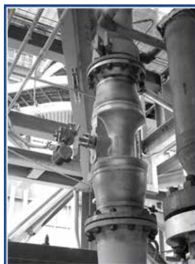
Accelabar de 12 pouces Plage de 272,16 à 16,49 tonnes par heure
