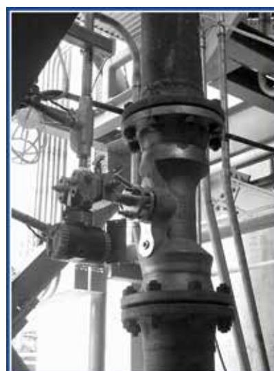
Accelabar de 6 pouces Plage de 40,82 à 5,44 tonnes par heure
