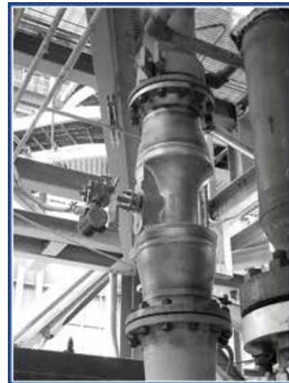
Accelabar de 12 pulg. Rango de 600,000 lb/h a 36,365 lb/h
