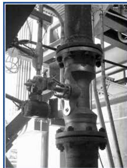
Accelabar de 6 pulg. Rango de 90,000 lb/h a 12,000 lb/h
